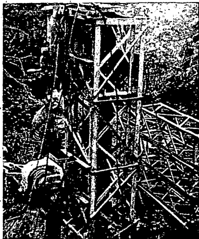
Tři snímky vítězné stanice OK1KHI. Montáž anténního stožáru z jednotlivých dílů
